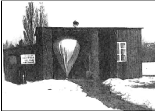
Abbildung 13 Die alte Füllhalle mit einem vergleichsweise kleinen Ballon der trotzdem bis zum Dach reicht. Ballone dieses Typs mußten vom Starter auf dem Bauch kriechend ins Freie gebracht werden
